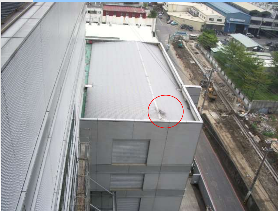
清洗作業區，輸配電線路與屋頂間距約4.7公尺
