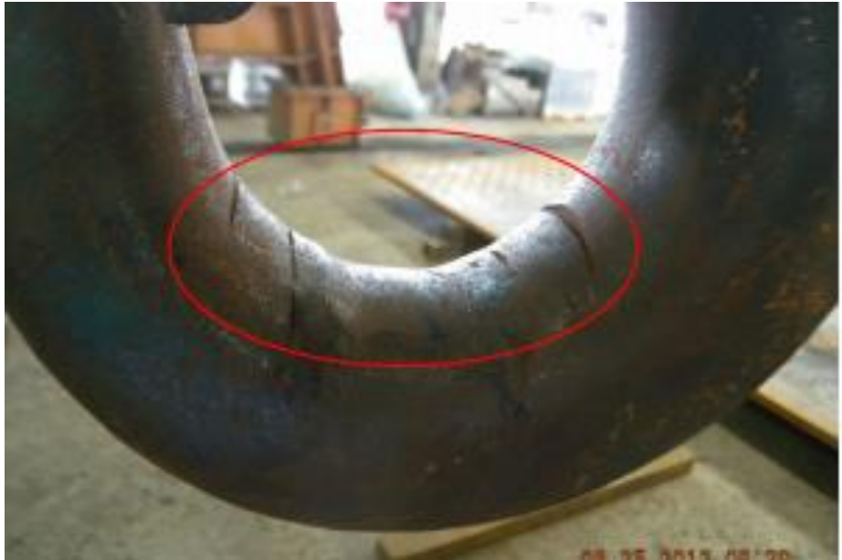
吊鉤下緣已龜裂
